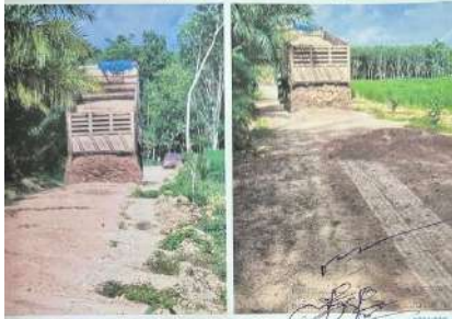
โครงการปรับปรุงถนนลูกรังสายบ้านนาควนหินทุก หมู่ที่ ๕
