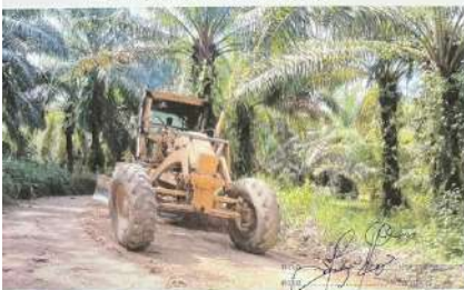
โครงการปรับปรุงถนนลูกรังสายหนองหิน-หินบุรี หมู่ที่ ๕
