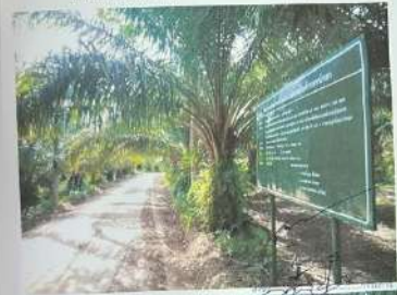
โครงการปรับปรุงถนนลูกรังสายบ้านนาควนหินทุก หมู่ที่ ๕
