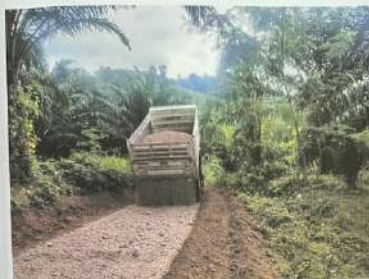
โครงการปรับปรุงถนนลูกรังสายหนองหิน-หินบุรี หมู่ที่ ๕
