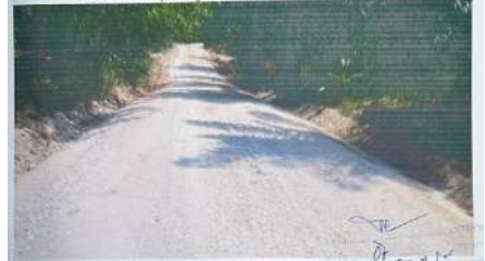
โครงการปรับปรุงถนนลูกรังสายนาเกลือ - สวนหินทอง หมู่ที่ ๒
