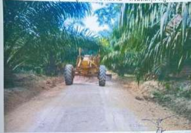
โครงการปรับปรุงถนนลูกรังสายนาเกลือ - สวนหินทอง หมู่ที่ ๒
