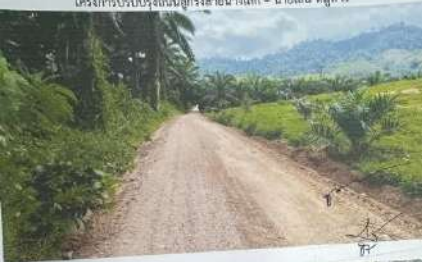
โครงการปรับปรุงถนนลูกรังสายนาเกลือ - นายสน หมู่ที่ ๗
