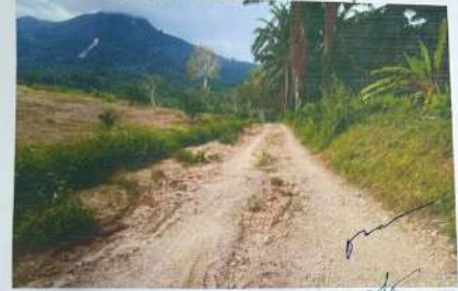
โครงการปรับปรุงถนนลูกรังสายนาเกลือ - นายสน หมู่ที่ ๗
