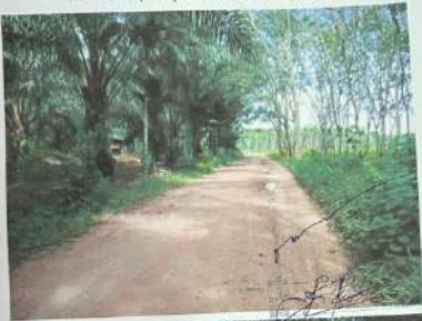
โครงการปรับปรุงถนนลูกรังสายบ้านนาควนหินทุก หมู่ที่ ๕
