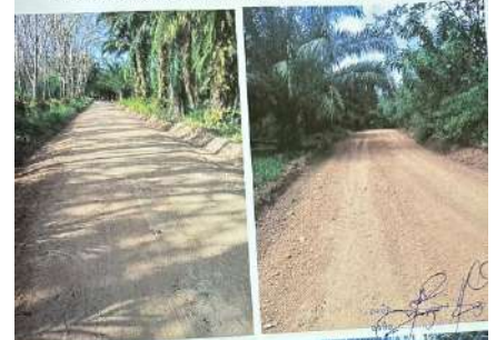
โครงการปรับปรุงถนนลูกรังสายบ้านนาควนหินทุก หมู่ที่ ๕
