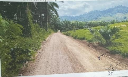
โครงการปรับปรุงถนนลูกรังสายบางเล็ก - นายเสน หมู่ที่ ๗
