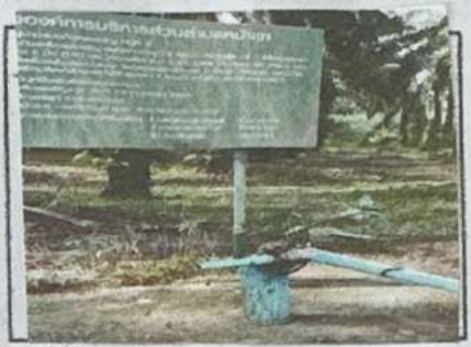
รูปที่ 1 ก่อนดำเนินการเป่าล้าง
