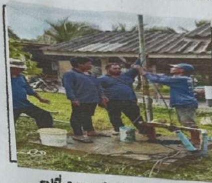
รูปที่ 2 ขณะดำเนินการเป่าล้าง
