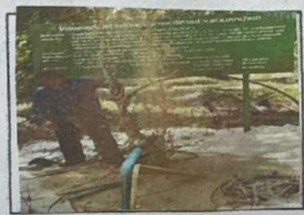
รูปที่ 3 ขณะดำเนินการเป่าล้าง
