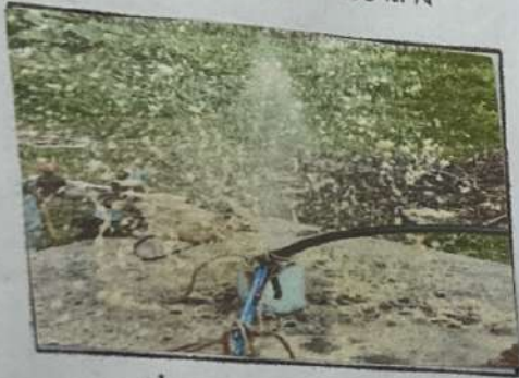
รูปที่ 3 ขณะดำเนินการเป่าล้าง
