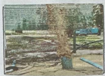
รูปที่ 2 ขณะดำเนินการเป่าล้าง
