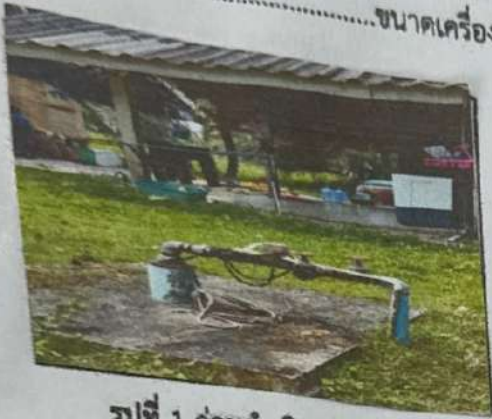
รูปที่ 1 ก่อนดำเนินการเป่าล้าง
